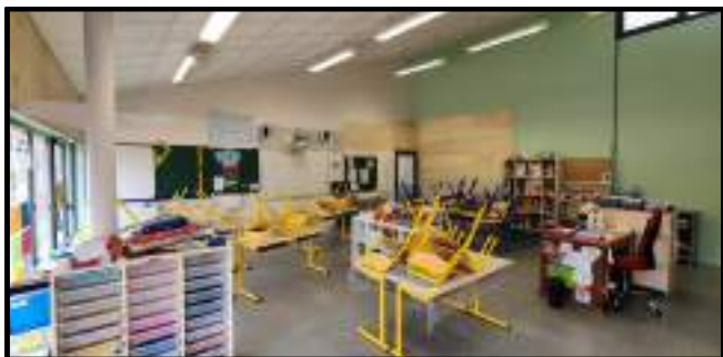
Réfection des peintures murales d'une salle de classe et installation de panneaux de protection en bois.
