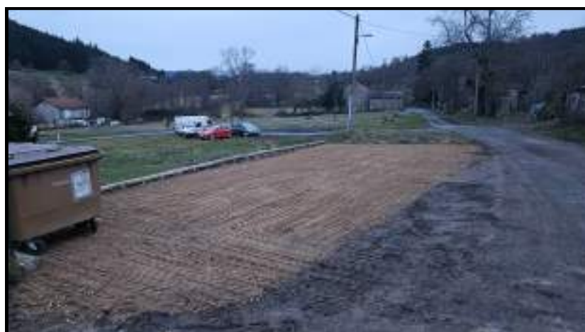
Agrandissement et stabilisation du parking sur le communal de Condros
