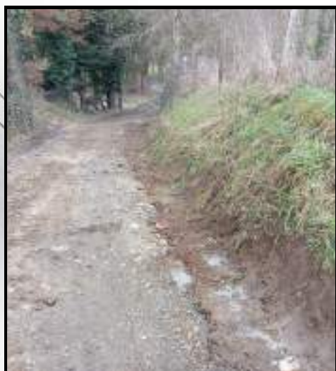
Reprise du talus et captation de l'eau de ruissellement à Céaux
