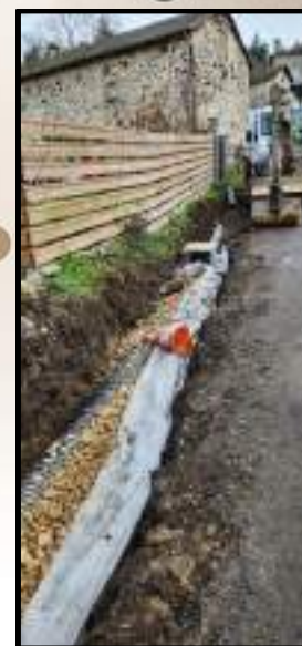
Captage de l'eau à Chamblas pour assainir la route communale
