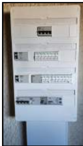
Migration du compteur électrique du sous sol de la salle polyvalente juqu'au balcon couvert de la cuisine.
